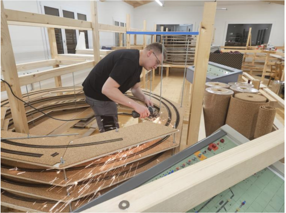
Oben: Ablängen der Gewindestangen am kleinen Wendel der Spur H0 durch Marc Ritschard. Unten: Anlagenplaner Tristan Fiechter begutachtet den Baufortschritt am grossen Wendel.
