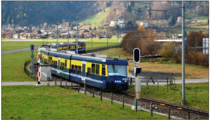
Ein bergfahrender Zug passiert die neue Blockstelle
